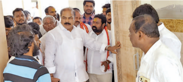
ఆనుపత్రి నిర్వాణ వసులను పరిశీలిస్తున్న కొమ్మూరి
